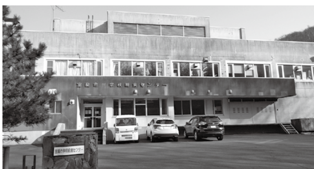
共同設置に向けて検討を進める学校給食センター
