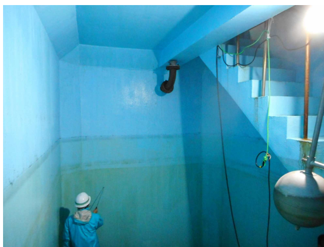
配水池内部点検
