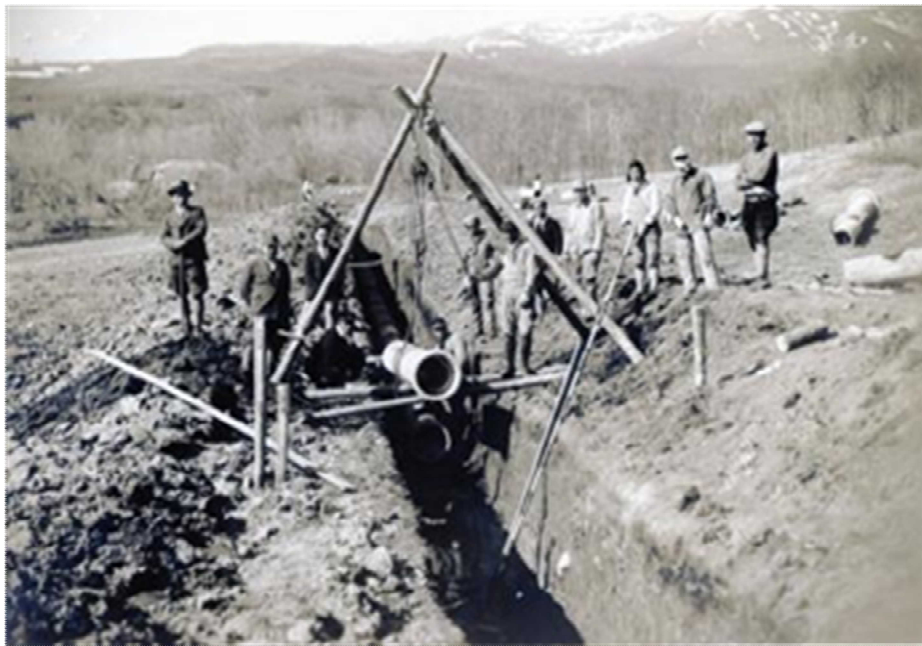
チマイベツ系送水管布設工事（第2期拡張工事）
