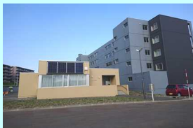
▲道営住宅と集会所
