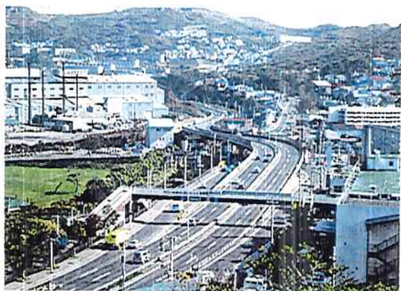
国道36号(母恋付近)
