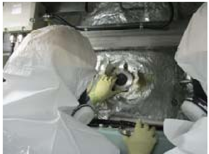
乾燥用溶剤加熱器サイトグラス (パッキン交換中)
