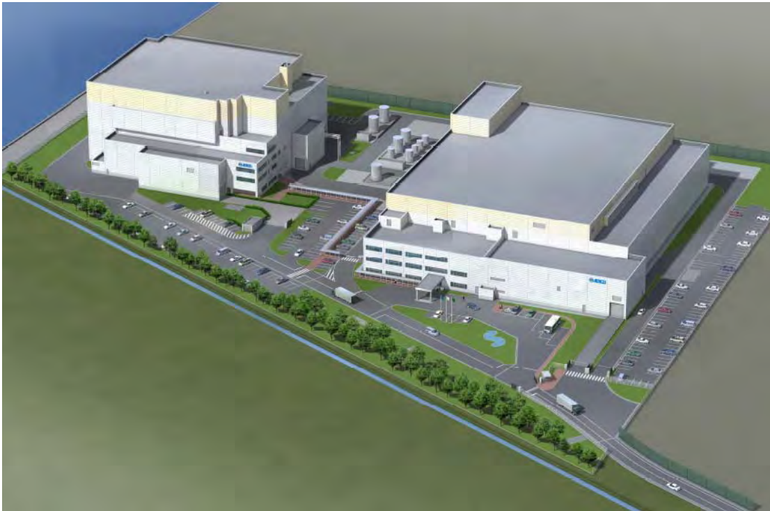
日本環境安全事業株式会社 平成23年10月
