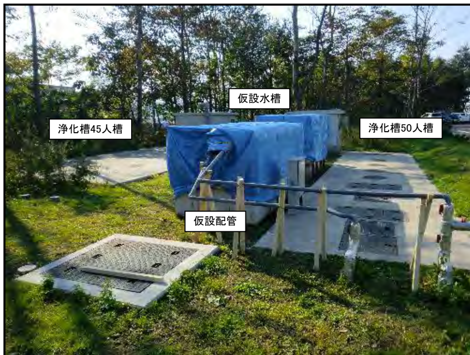
浄化槽及び仮設配管等の設置状況
