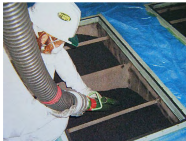
活性炭交換作業 (抜き出し状況)
