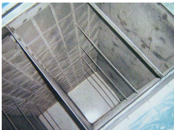
抜き出し完了状態
