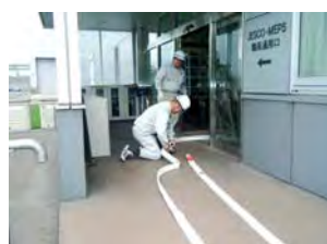
消火ホース接続・敷設
