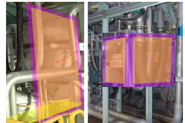
[飛散防止カバーの設置]
