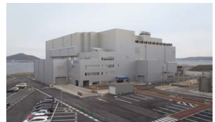
当初施設4Fより増設施設工事現場を見たところ
