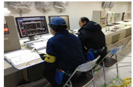
試運転状況(中央制御室)
