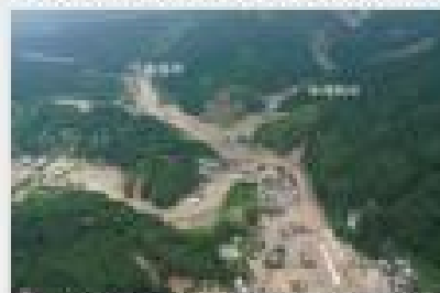
2017年の九州北部豪雨による被害 福岡県東海市の赤川(小野町)に乙武河合流点付近に流れる洪水の被害(7月26日撮影) 出典: 国土交通省「平成29年7月九州北部豪雨による土砂災害の概要」(速報版)より作成
