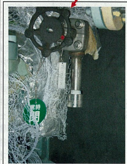
ドレン弁及び出口部 (応急措置後)
