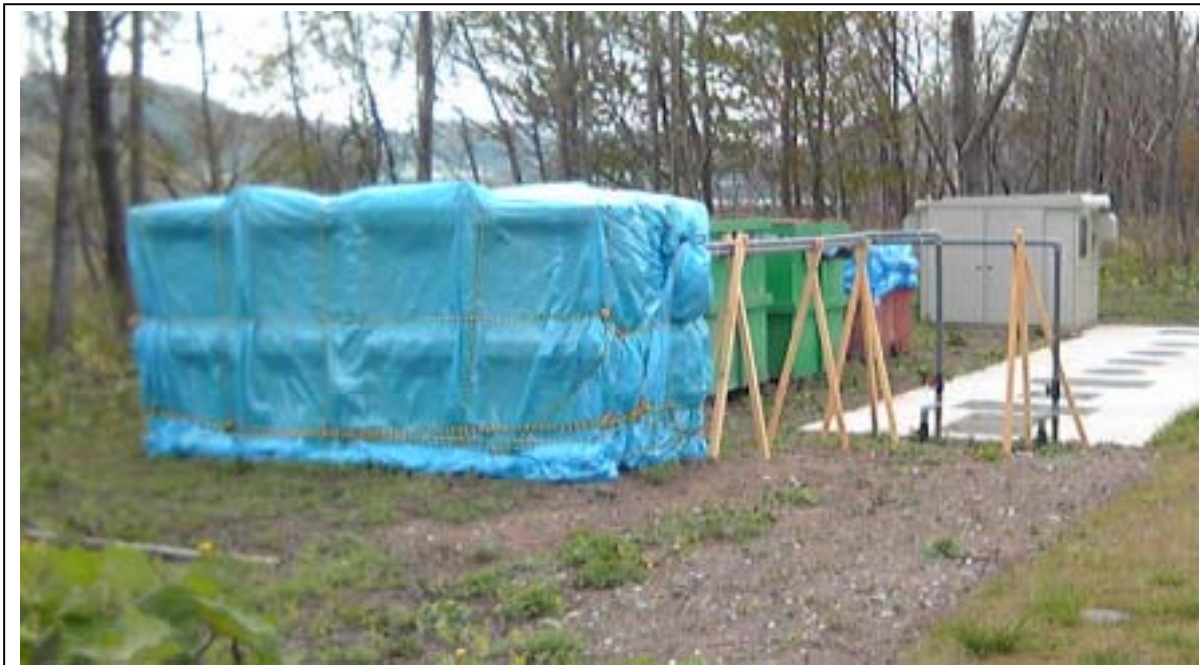
仮設水槽及び仮設配管の設置状況
