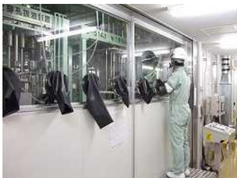
コンデンサ解体ライン
