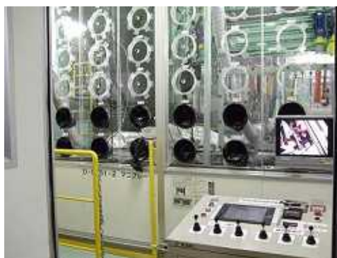
特殊解体ライン
