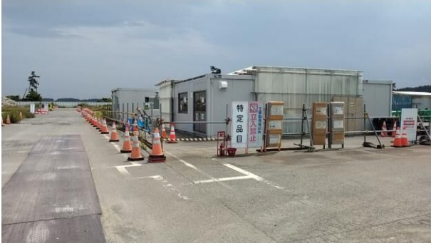
写真1：保管場所の全景
