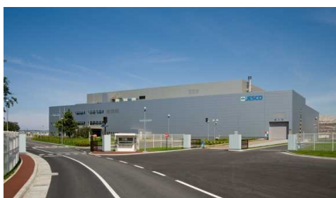
北海道PCB廃棄物処理施設（外観）
