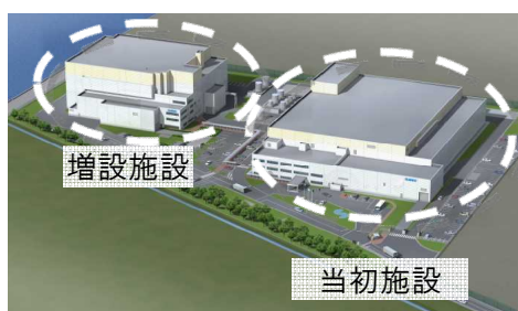
当初処理施設と増設処理施設
