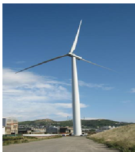
茶津第一風力発電所
