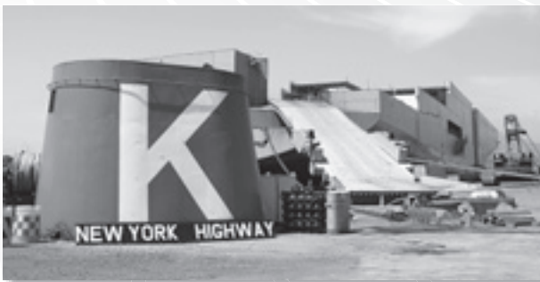
自動車運搬船の解体実験がスタート（3月9日） ※写真は解体中（6月7日）の様子
