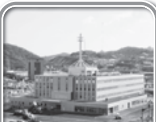
平成21年2月 駐車場の舗装工事が進む
