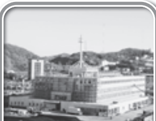
平成20年11月 外壁工事が着々と進み、窓ガラスのはめ込みはほぼ完了
