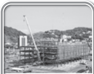
平成20年7月 鉄骨が組み立てられ、ビル の大きさがわかるよ うになる
