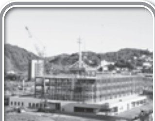
平成20年9月 アンテナの設置が完了。1階部分の外壁が取り付けられる
