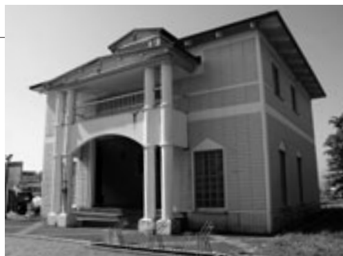
大正公会堂トイレ (入江温水プール付近)
