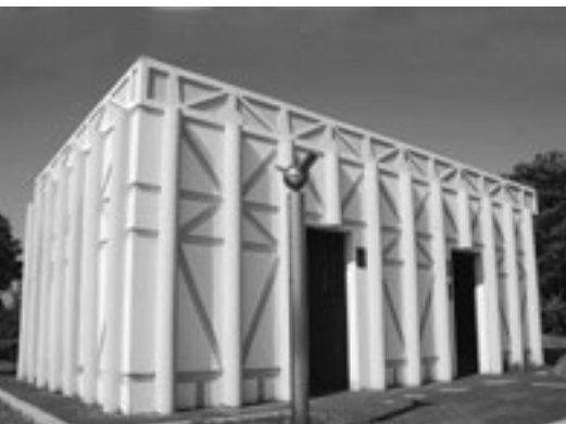
高架棧橋トイレ (入江陸上競技場)
