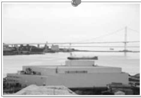
北海道と東北など、15県分のPCB廃棄物を処理する、「北海道PCB廃棄物処理施設」の試験運転が開始。来年4月に本格稼働の予定。（3月22日）
