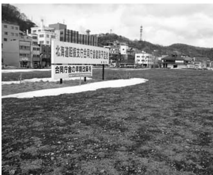
北海道から胆振支庁の入居が示された、(仮称)入江地区広域センタービル建設予定地(海岸町)。
