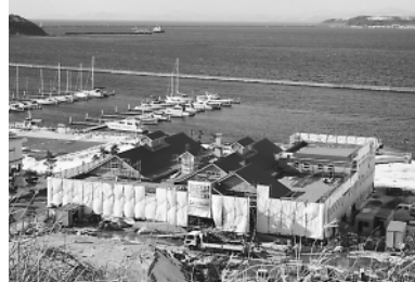
5月のオープンを目指して建設が進む温泉施設。祝津絵鞆地区のにぎわいが期待される
