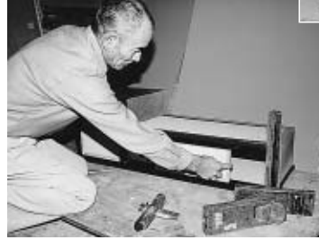
木材を正確に切り、釘は一切使わず組み立てていく。
