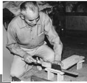
木材を正確に切り、釘は一切使わず組み立てていく。
