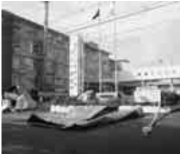
瞬間最大風速45.7メートル。台風18号の強風により大きな被害を受けた
