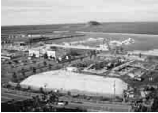
祝津地区での温泉施設工事(平成17年4月オープン予定)
