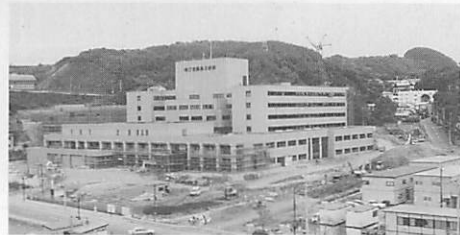
来年6月開院を目指して着々と工事が進む、新市立病院
