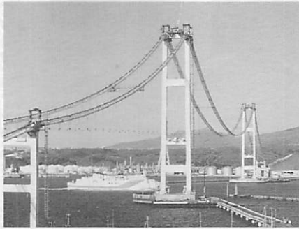
ハンガーローブ取り付けも完了し いよいよつり橋らしくなる(11/9)
