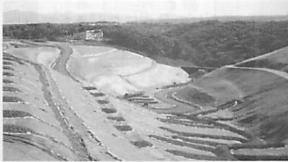
新最終処分場(11/1)
