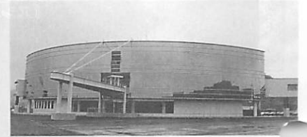
流通の拠点フェリーターミナルビル(4/19)
