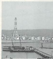
海上部で主塔の積み上げが始まる白鳥大橋工事
