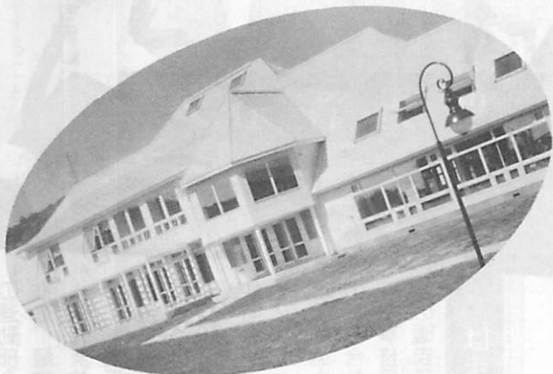
▲ 花と工芸の館 花、風、光をテーマに、洋ランや藤家具、ステンドグラスなどを展示販売する『エレガ』が、中島本町に6月16日オープン。純白の屋根、ピンクの外壁に包まれた南欧風の館が、マチの魅力を更新に引き出すだろう。
