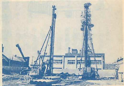
▲ 1日・(仮称)室蘭・登別保健センター工事始まる
