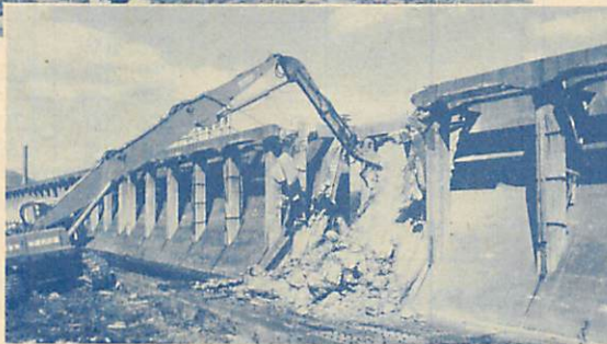
▲13日・64年国体をめざし入江運動公園事業に 着手。高架橋の解体始まる
