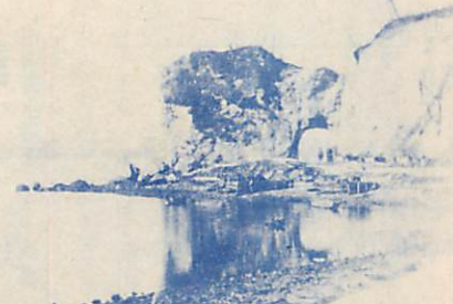
茶津岬廻り新道トンネル
