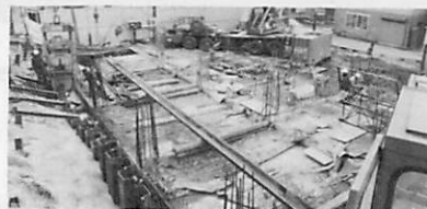
建設進む輪西ポンプ場
