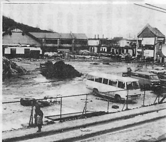
解体作業が進められている旧校舎
