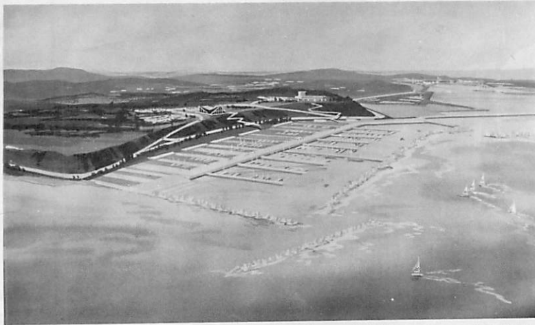
ヨットなどのマリーナ施設、崎守町ポロシレト地区の海洋性レクリエーション基地
