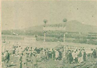
上水道第四期拡張工事始まる(起工式)
