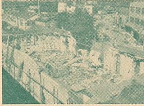
解体作業中の社会会館
