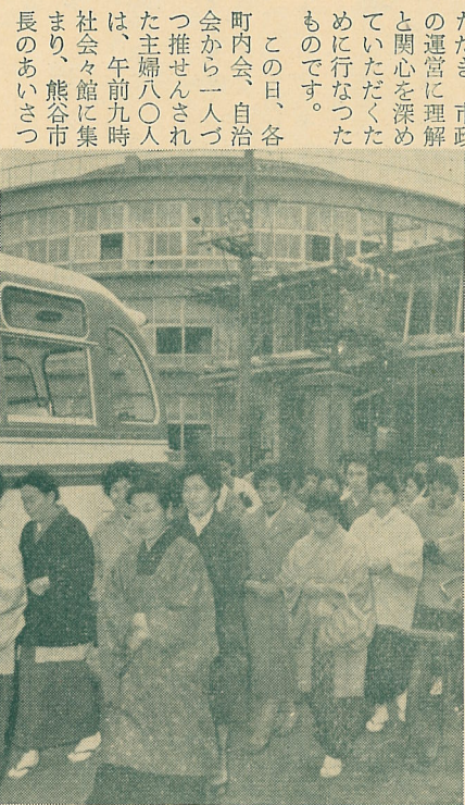
絵鞆小円型校舎工事現場を見るおかあさんたち
