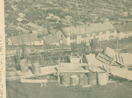
工事中の母恋高区配水池
