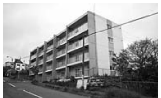
平成19・20年度予算で建設した舟見町の市営住宅
