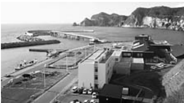
完成に向けて建設が進む追直漁港のMランド
