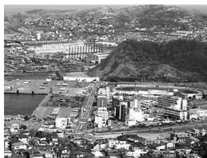
渋滞緩和や流通機能の拡大のため臨港道路が新設される入江地区
