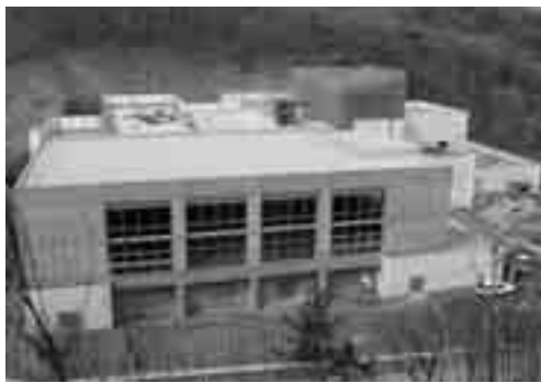
平成18年度開校に向け工事が進む星蘭中学校
