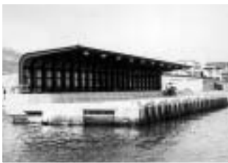
② 防風施設
