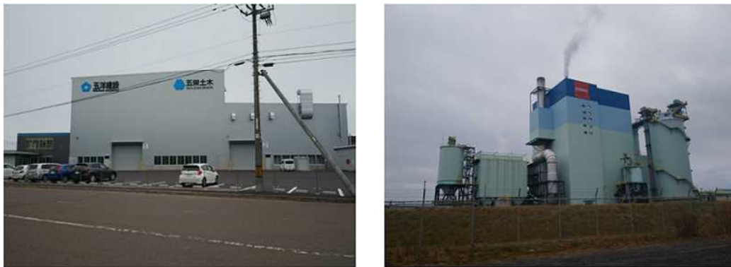
図12 洋上風力部材を製造する新工場（写真左）と木質バイオマスのみを燃料とする発電所としては国内規模最大のバイオマス発電所（写真右）
