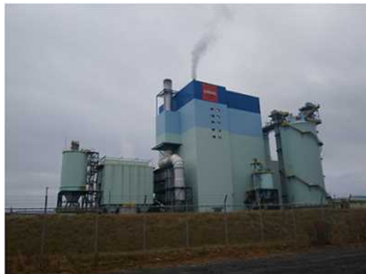
木質バイオマスのみを燃料とする発電所としては国内最大規模の室蘭バイオマス発電所
