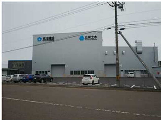
洋上風力部材を製造する五洋建設株の新工場(ZEB)
