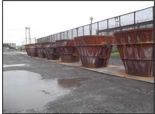
スラグ冷却場(平成 29 年 3 月 ~)
