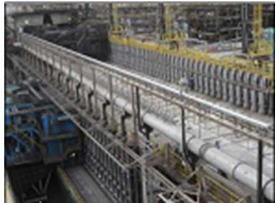
第5 コークス炉東炉改修後
