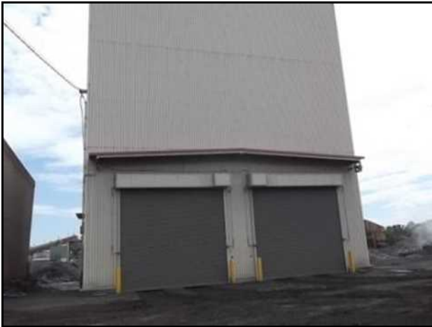
排滓小屋(平成 29 年 5 月 ~)
