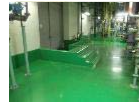
〔不浸透塗床〕 特殊な樹脂により、万が一の場合でも、床面へのPCB油の浸透を防止
