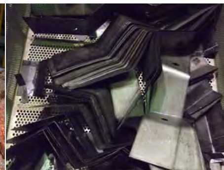
⑧ 鉄心解体
