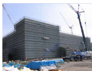
北側（蒸留エリア、払出室）
