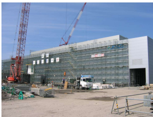
正面（右側がPCB受入室）
