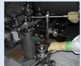
トルクレンチを使用したボルトの締め付けの様子
